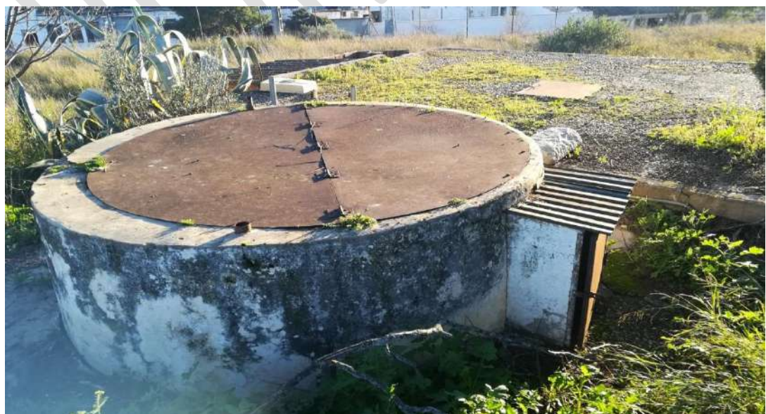
Lámina 7. Fotos del Depósito de Aguas.
